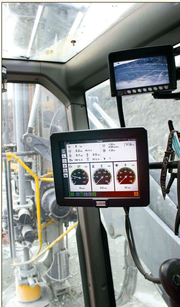
L'écran de contrôle d'une foreuse.
