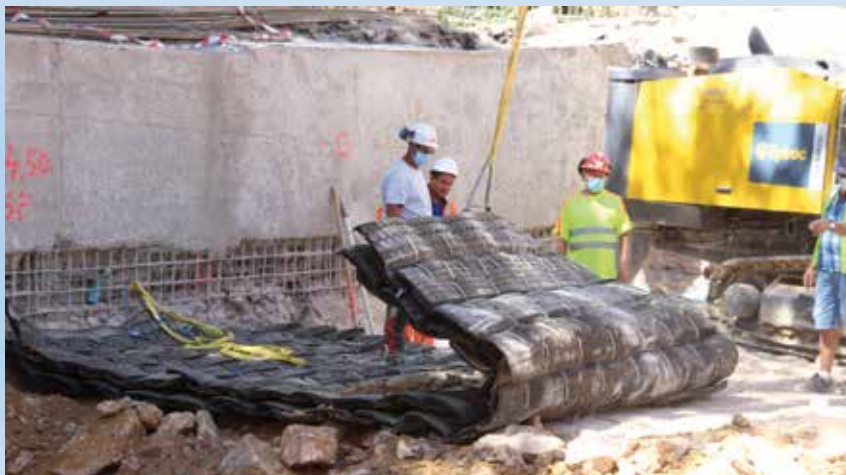
L'ensemble du pas de tir est ensuite recouvert par des tapis de protection de 1,3 tonne.
